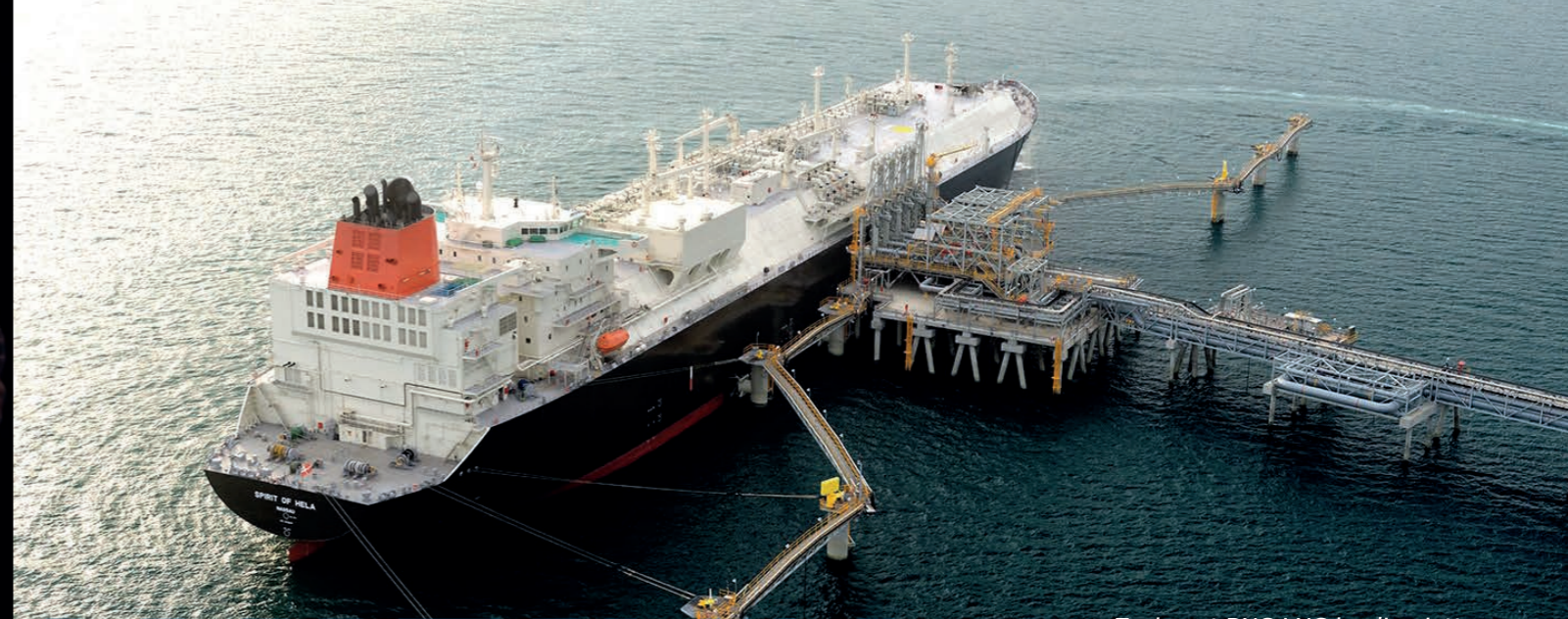
Tanker at PNG LNG loading jetty
